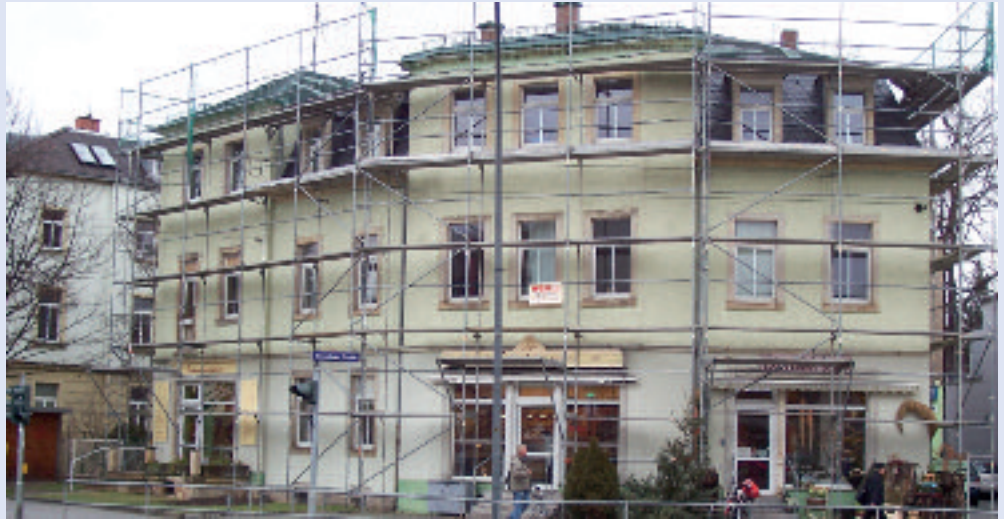
Haus eingerüstet, Arbeiten zur Wärmedämmung, Einbau neuer Fenster, Modernisierung der Heizung – nach dem Willen der Bundesregierung künftig drei Monate lang kein Anlass zur Mietminderung
